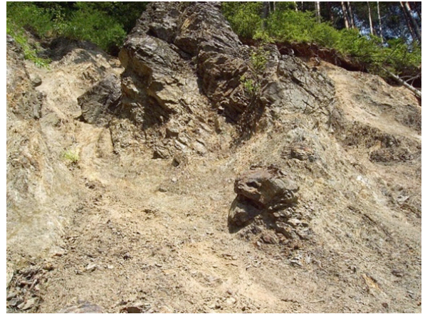
図6 南露頭 中央壁面の断層破碎帯
