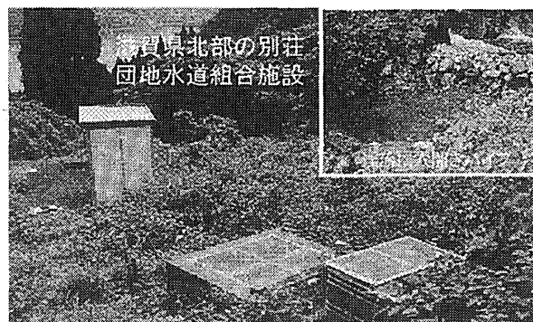
図 14. 溪流に穴あきパイプを埋設し、濁りが少ない水を取水する。砂利での濁りを粗ろ過し、砂ろ過をする。この二つのろ過槽には、フェルト状の不織布を砂利や砂の上に敷設している。ろ過池へ流入する濁りを除くに維持管理が楽である。
