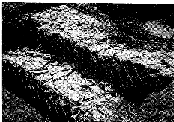
写真2. 設置された蛇籠
