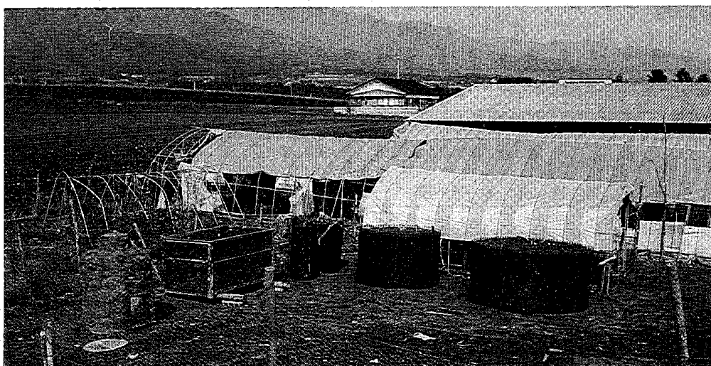
写真-2. 熟成槽の設置状況
