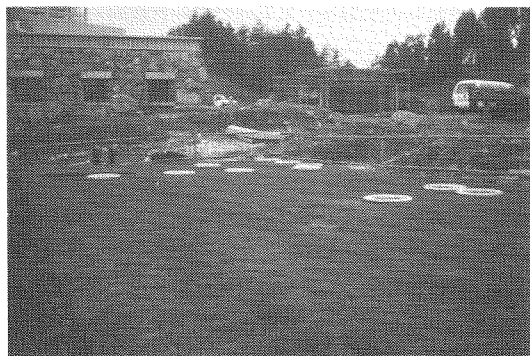
写真一28 土壌被覆接触曝気槽の全景
