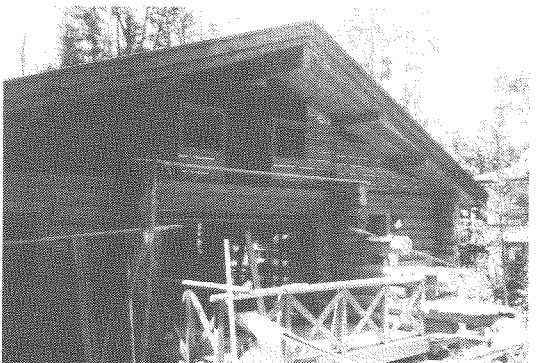
写真-14 建設中のログハウス
