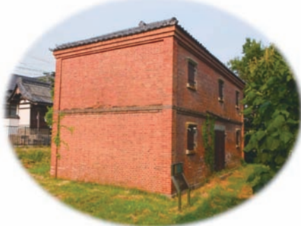
改修前の全景
