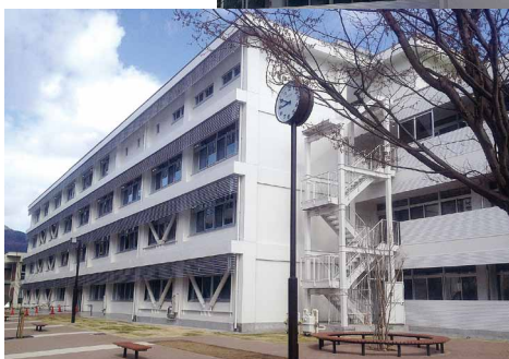
文責 北校舎耐震改修検討委員長 宮崎樹夫
