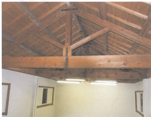
2 階天井の梁組
