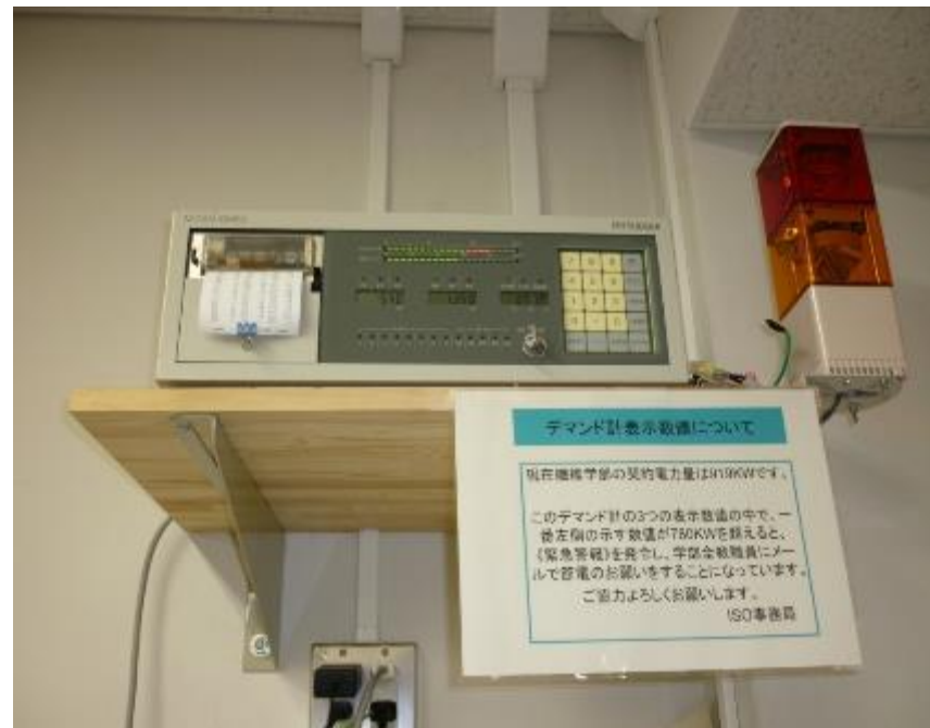
事務フロアに設置している デマンド計
