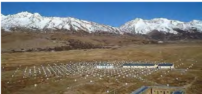
図3：チベット高原(標高4300m)に設置された空気シャワーアレイ
