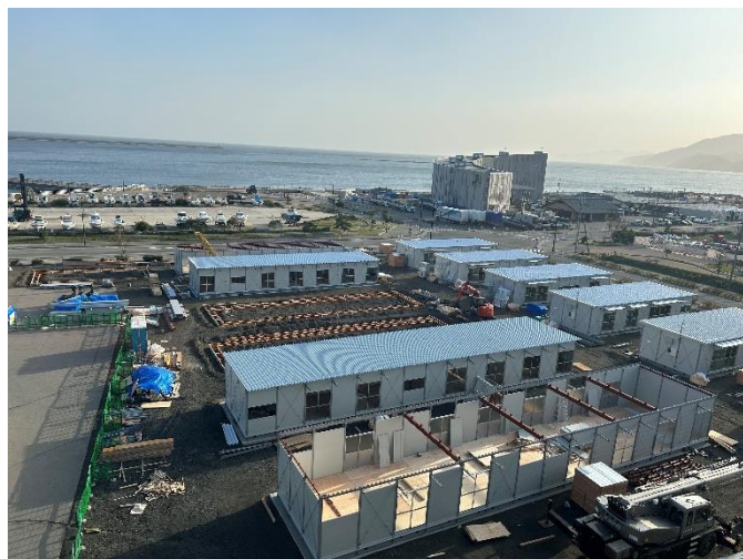
輪島の仮設避難所建設（橋本英樹先生 ご提供）
