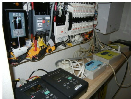
住宅における消費電力量や太陽光発電と燃料電池の発電量を計測する計測器を設置した様子
