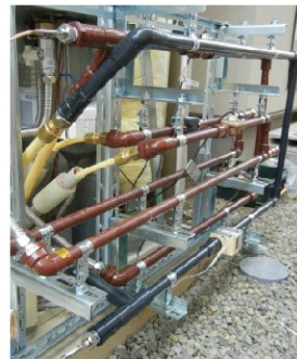
燃料電池の効率を計測するためのセンサーを設置した様子
