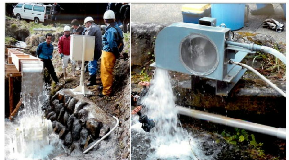
湧水で発電する滝水車(左)と、温泉水によるジェット水流で発電するジェット水車(右)。それぞれ電気柵と衛星電話の電源に利用
