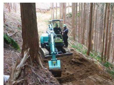
図 24 バックホウによる作業道開設
