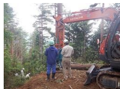
図 25 スイングヤードによる集材作業
