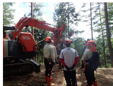
図 31 スイングヤードによる集材作業
