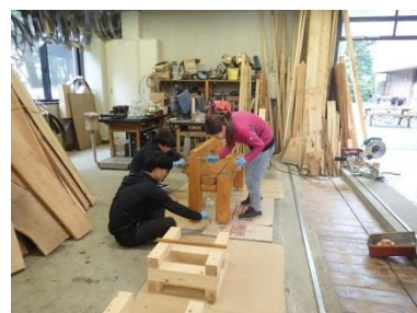
図18 木材保護塗料の塗装作業
