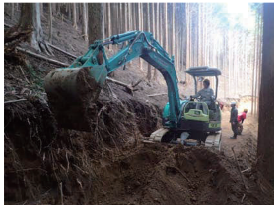
図-20 バックホウによる路網開設作業
