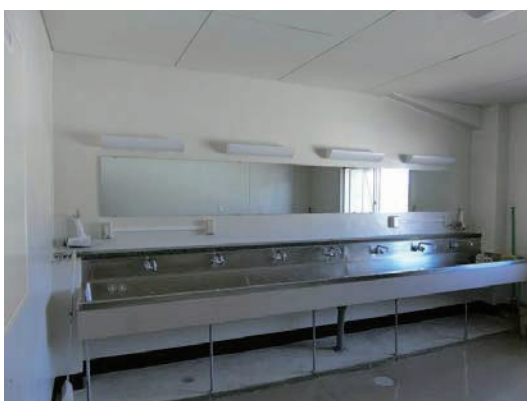
図7 宿泊棟2F洗面所に ドライヤーを新設（2台）
