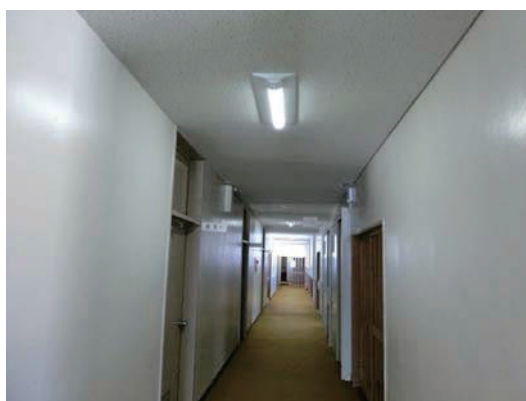
図9 宿泊棟廊下の照明
