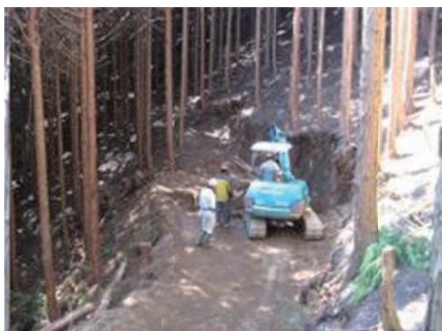
図-37 バックホウによる路網開設作業
