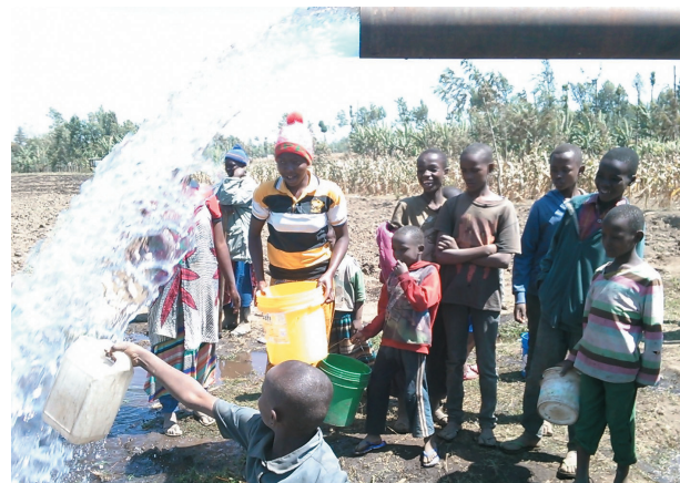
タンザニア政府アルーシャ県の地下水源。メルー山の中腹 標高1,600mに掘られたばかりのボアホール。新しく掘削されたボアホールの地下水も、今後、河川水源の水とミックスして市街地に配水される予定。
